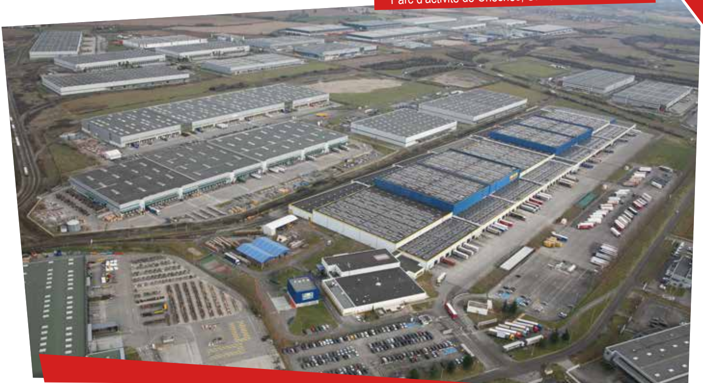
Parc d'activité de Chesnes, Saint-Quentin Fallavier
